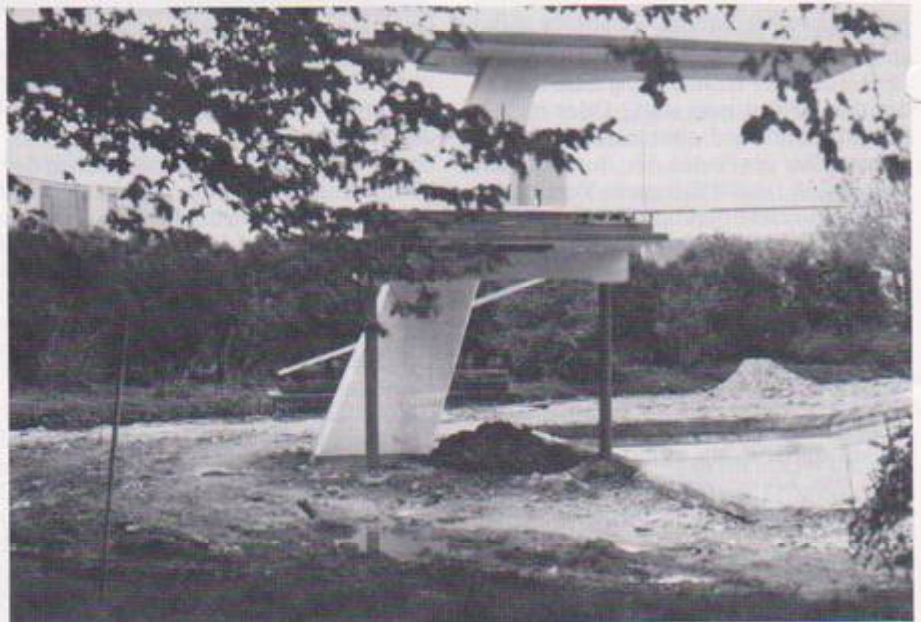
Eine Baustelle ist das Freibad in Neustadt. Der gesamte Umfangsbereich des Schwimmbeckens ist abgetragen, das darunterliegende Füllmaterial deutlich erkennbar, der Sprungturm (links) wird dieses Jahr niemandem die Möglichkeit eines Sprunges in das kühle Nass geben. Ob das im Sinne der Schwimffreunde liegt, darf bezweifelt werden!
