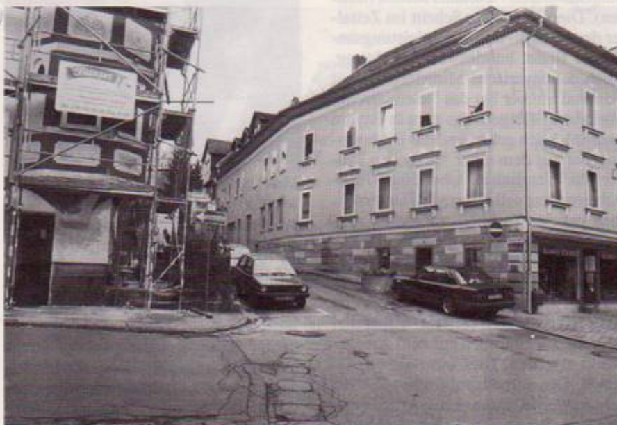
Bild vom Haus Blumen-Eckardt und Haus Simon: Das Haus Steinweg 10 erstrahlt bereits im neuen Glanz. Am Nachbarhaus, Rosenstraße 1, ist die Verschönerung noch im vollen Gange.
