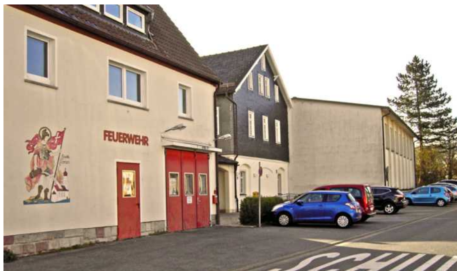
Das Feuerwehrgerätehaus in Wildenheid - das Obergeschoss steht leer und darf aufgrund der zu geringen Raumhöhe nicht genutzt werden. Auch die Parksituation ist nicht gerade ideal, wenn nebenan Schulunterricht ist. Im Falle eines Einsatzes finden die Aktiven praktisch keinen Parkplatz mehr!
